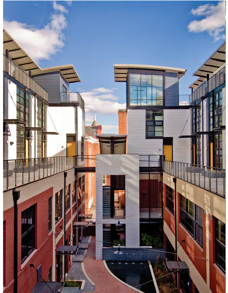
Torre de escalera End stair tower
